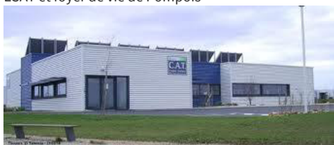
ESAT et foyer de vie de Pompois
