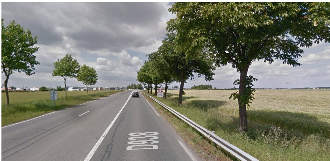
Entrée sud de l'agglomération thouarsaise en provenance de Niort – Source : Google Maps
